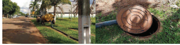
Figura 116: Destinação de resíduos na rede coletora de esgoto do município de Presidente Castelo Branco. Fonte: EnvEx Engenharia e Consultoria (2020).
