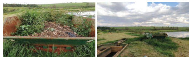
Figura 112: Armazenamento de resíduos de gradeamento e desarenador na ETE de Presidente Castelo Branco. Fonte: EnvEx Engenharia e Consultoria (2020).
