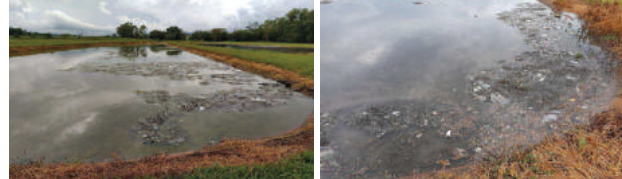
Figura 113: Resíduos grosseiros na lagoa de tratamento de esgoto na ETE de Terra Rica. Fonte: EnvEx Engenharia e Consultoria (2020).
