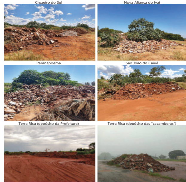
Figura 102: Áreas de armazenamento de RCC para posterior reutilização. Fonte: Envêx Engenharia e Consultoria (2020).
