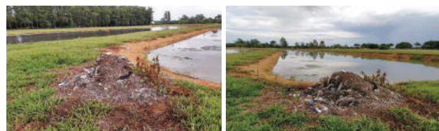
Figura 114: Armazenamento de resíduos grosseiros ao lado da lagoa de tratamento de esgoto na ETE de Terra Rica. Fonte: EnvEx Engenharia e Consultoria (2020).
